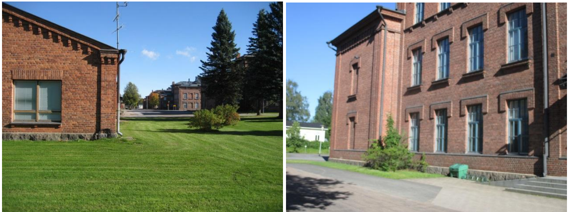
Kuvat 18 ja 19. Rakuunamäen eteläosan kasarmirakennuksia ja hoidettuja pihalueita niiden ympärillä.
